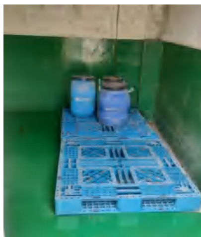
一般固废暂存间内部
